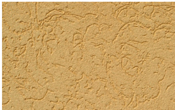
бороздчатая структура (круговая затирка поверхности)
