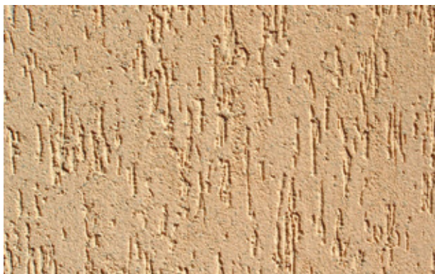
бороздчатая структура (вертикальная затирка поверхности)
