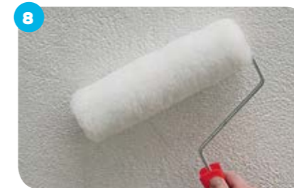
8 Для укрепления и тонирования основания, а также для увеличения адгезии нанести грунтовку weber.prim Uni.
