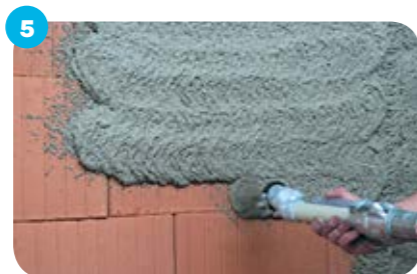
5 Приготовить раствор согласно инструкции на обратной стороне мешка (при ручном нанесении штукатурки) или в штукатурной станции (при машинном нанесении).
