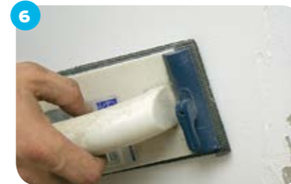
6 Зашкурить наждачной бумагой и обеспылить старую окрашенную поверхность.
