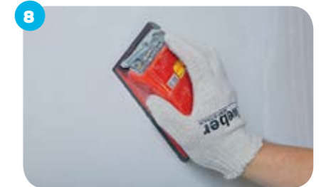
8 Высохшую поверхность обработать шлифовальной бумагой и обеспылить. Каждый следующий слой наносить на полностью высохший предыдущий.
