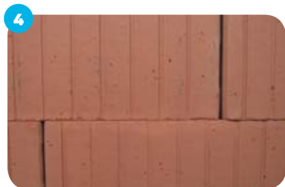
4 Основание должно быть чистым, сухим, обеспыленным. Сильно впитывающие основания необходимо обработать грунтовкой weber.prim multi.
