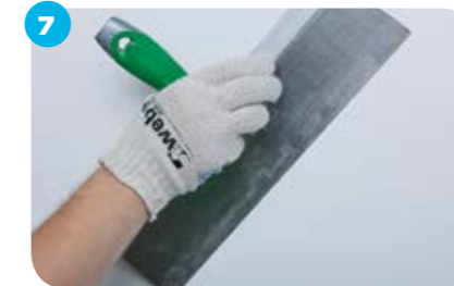
7 Нанести на поверхность смесь weber.vetonit JS вручную с помощью двуручного стального шпателя или механизированным способом напыления.
