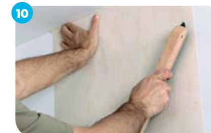
10 Через 1-2 сут. в зависимости от толщины слоя поверхность готова к финишной отделке.
