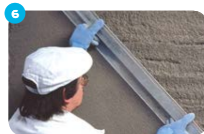
6 Нанести раствор webervetonit 414 толщиной 5–30 мм (10–12 мм за один слой) и разровнять с помощью правила. Большую толщину можно получить повторным нанесением с промежуточной сушкой первого слоя не менее 24 ч.
