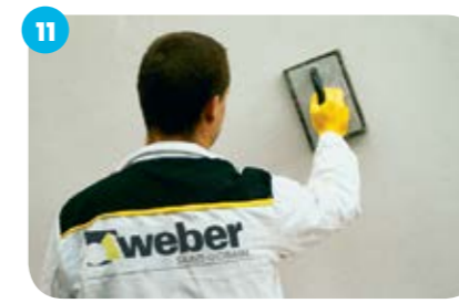
11 Не дожидаясь обветривания поверхности, создать фактуру, затирая поверхность пластиковой теркой. Спустя 3–5 дней поверхность можно красить.
