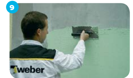
9 1-й вариант Не ранее чем через 24 ч. после обработки основания грунтовкой weber.prim Uni нанести декоративную силикатно-силиконовую штукатурку weber.pas extraClean, колерованную в объеме.
